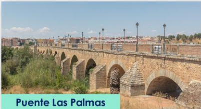
Puente Las Palmas
